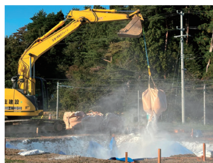
写真：埋却溝への石灰散布の様子
