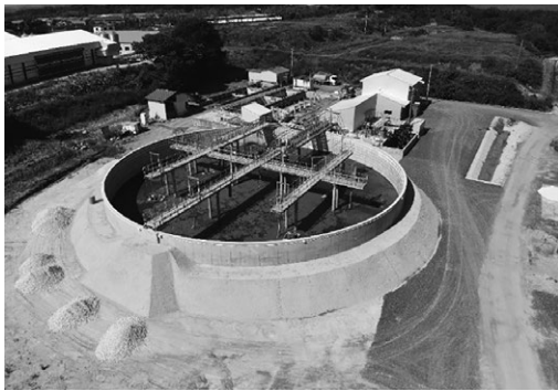
(写真3 浄化槽施設)
